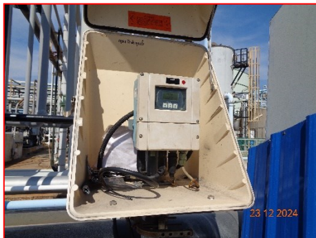
(27) Conductivity Online Analyzer บริเวณก่อนระบบ ออกนอกโครงการ
