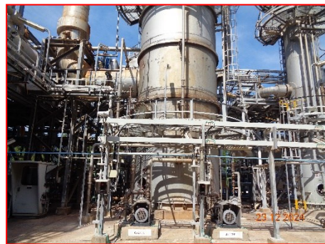
(5) ปั๊มสูบล้าง NaOH บริเวณ Off Gas Scrubber
